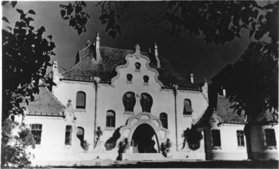
11. A kastély főhomlokzata, fénykép. MÉM-MDK Ltsz:17.012
